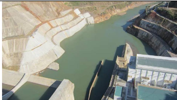
Hình 5: NMTĐ Sê San 4, bồi lấp sau kênh ra nhà máy
