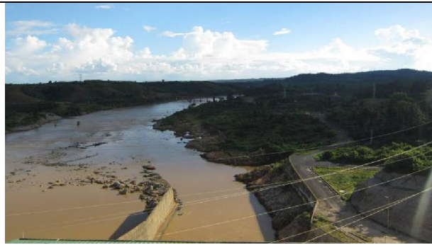
Hình 5: NMTĐ Sê San 4, bồi lấp sau kênh ra nhà máy
