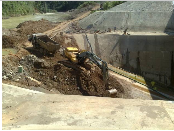
Hình 4: NMTĐ Xekaman3, bồi lấp xói lở cửa ra và sau cửa ra nhà máy
